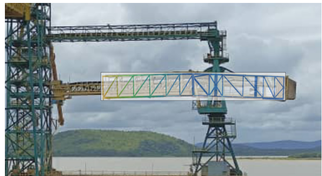
Figura 15: Comparación de forma deformada obtenida de simulación con modelo A y evidenciada en campo.
